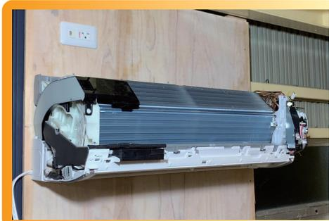
① エアコンを分解・洗浄前に周辺をしっかりと養生します。エアコンを洗浄できる状態まで分解します。
