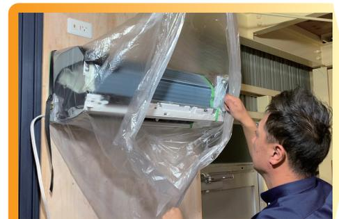
⑥ エアコンを洗浄します。エアコン本体上部の養生マスキングは洗浄しやすくするために上にめくりあげて洗浄してください。
