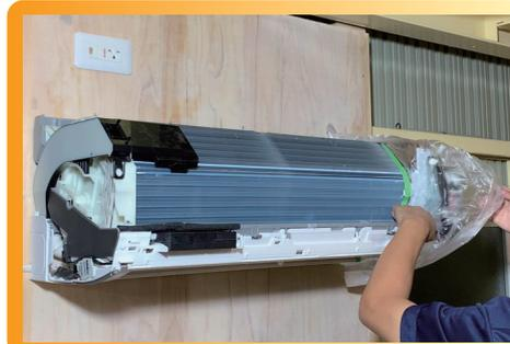
② エアコンの電装部分（基盤やモーター等）があれば養生マスキングでしっかりと養生します。
