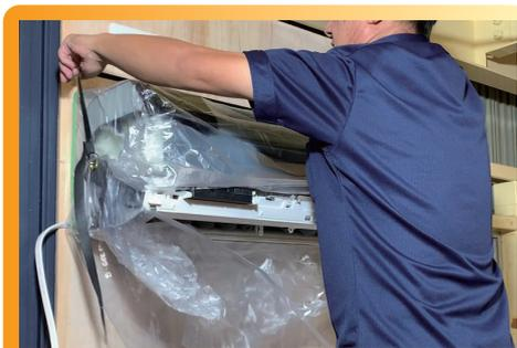
④ ホッパーのゴムバンドを両手でエアコン上部に引っ掛けて装着します。エアコン本体に巻いた養生マスキングを広げてホッパー内に入れておきます。ゴムバンドの長さは縛る位置を変えて調整してください。
