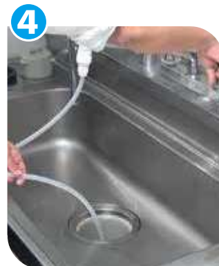
水道の蛇口を全開にして、洗浄 します。
