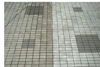
洗浄前 洗浄後 磁器タイル 外床の洗浄
