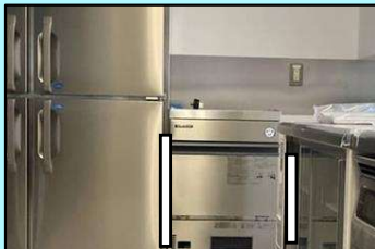
厨房機器の隙間
